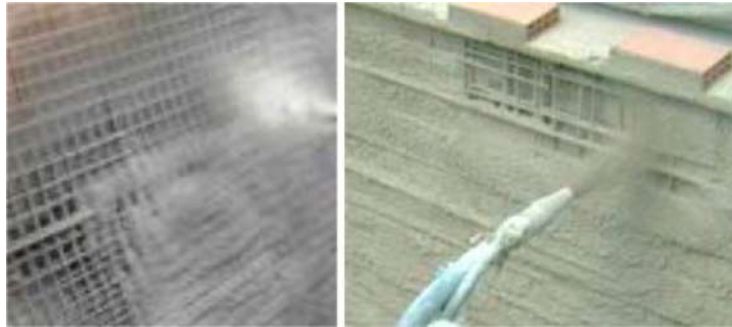
Şəkil 4. Beton (shotcrete) qarışığının püskürtmə üsulu ilə tətbiqi
