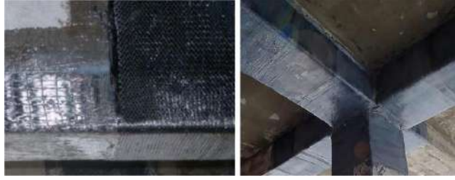
Şəkil 2. Dəmir-beton konstruksiya elementinin karbon lifli parçalarla gücləndirilməsi
