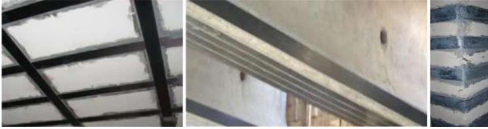
Şəkil 3. Dəmir-beton konstruksiya elementinin karbon lifli lamellərlə gücləndirilməsi
