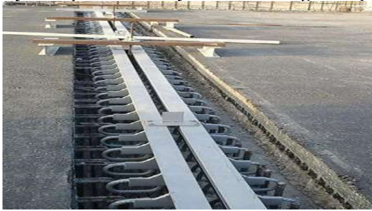
Şəkil 2. Deformasiya tikişi konstruksiyasının quraşdırılması.
