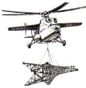
Şəkil 3. Elektrik xətti dayağının SK-24 markalı helikopterlə nəql olunması
